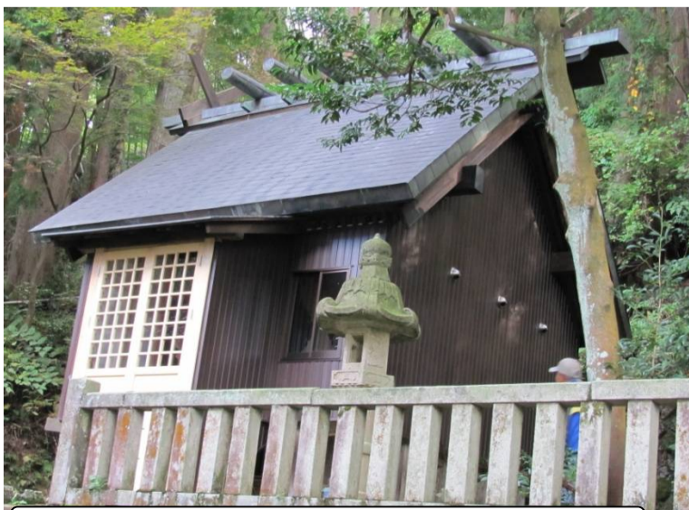
11月23日 諏訪神社・奥の院修理工事が完了
